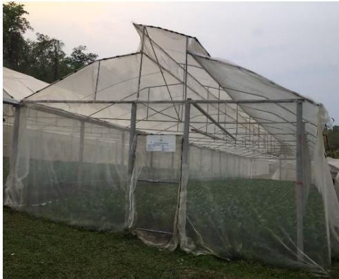
รูปที่ 4. รูปแบบของโรงเรือนรูปทรงกอไก่ประยุกต์
