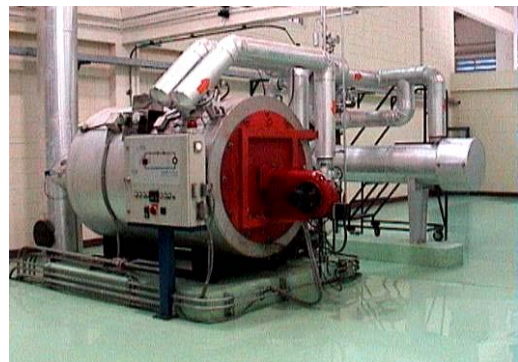
รูปที่ 1 หม้อต้มน้ำมันร้อน (Thermal Oil Boiler)
